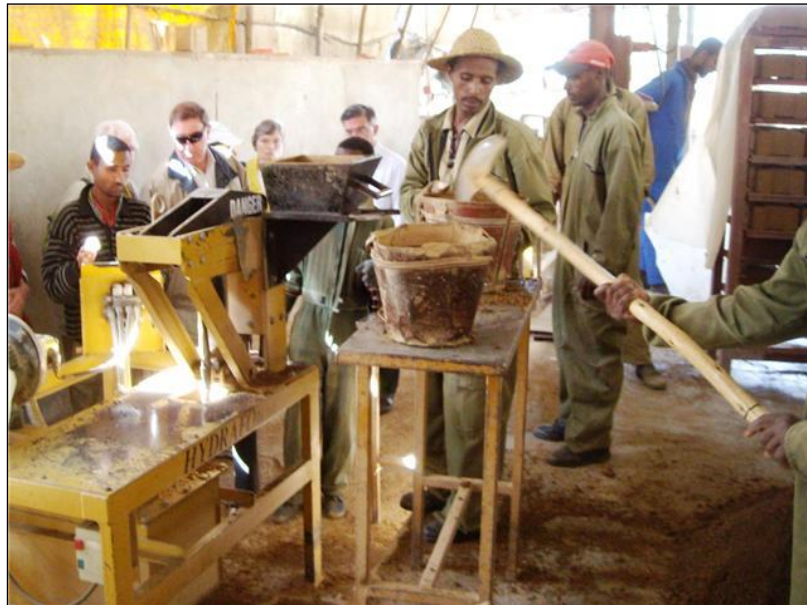
Die richtige Mischung aus Braunerde, Wasser und Zement wird hergestellt. (Bild, J.Bachofner)
