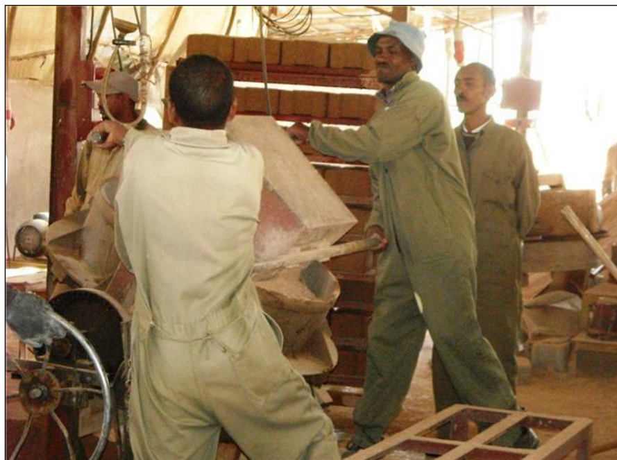
Die Erdbausteine werden mit der Steinpresse in Form gebracht. (Bild J.Bachofner)
